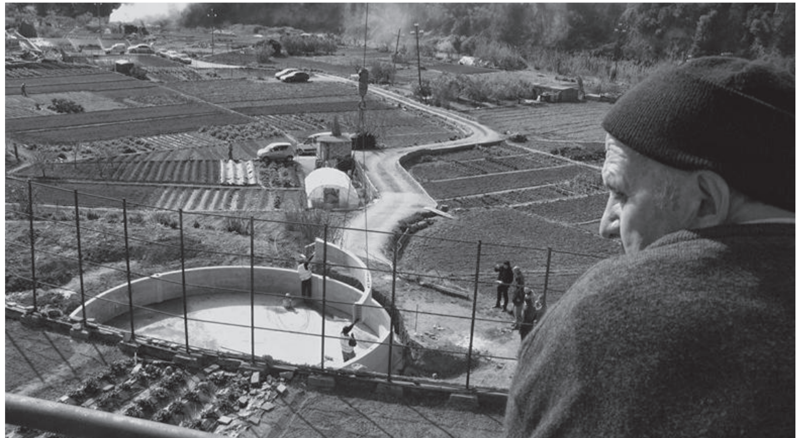
▲ Das Rückhaltebecken und der neue Weg durch die Obstgärten
