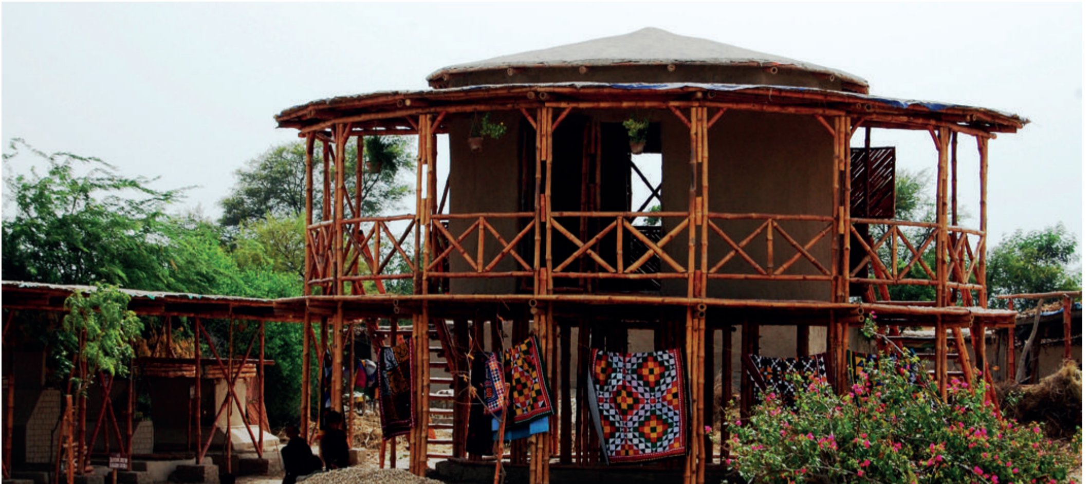
▲ Eigene hochwassersichere Räume für Frauen
